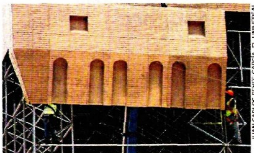
La fachada, del proyecto del arquitecto Pablo Manuel Calles, aún está en construcción.
