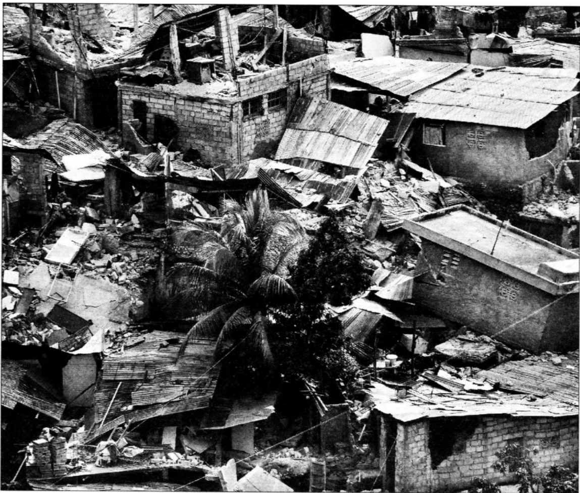
Incontables daños a la infraestructura de Puerto Príncipe provocó el terremoto de 7 grados Richter ocurrido el martes pasado ■ Foto Reuters
