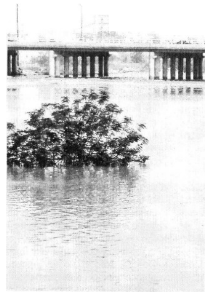
DESFOQUE. La presa Lázaro Cárdenas La Angostura se encuentra saturada
