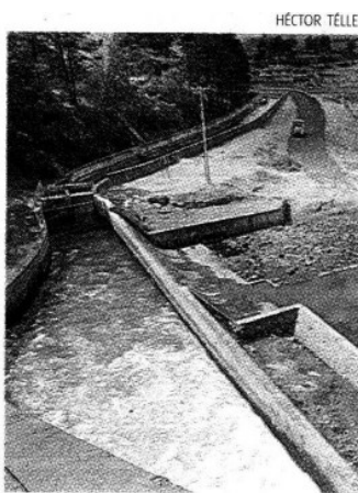
Obras de mantenimiento, la causa
