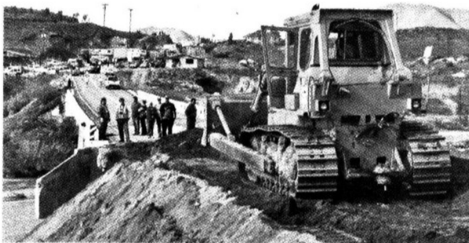
► El puente de San Vicente, en Ensenada, ya fue reparado.
