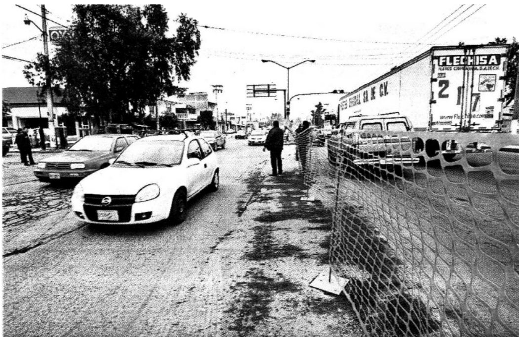
> Sobre la avenida Henry Ford se construirá un distribuidor vial, para agilizar la circulación.
