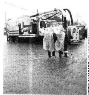
BOMBEO. Los camiones vactor fueron insuficientes
