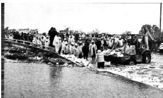
ECATEPEC. En Periférico Oriente se colocaron costales para impedir la inundación de la vialidad.
