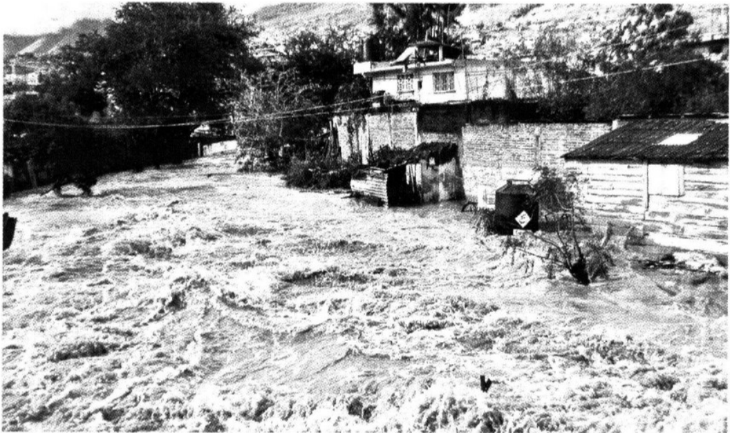
ANEGADOS. El desfogue de la presa "El Cerrito Rico" dejó bajo el agua decenas de viviendas.
