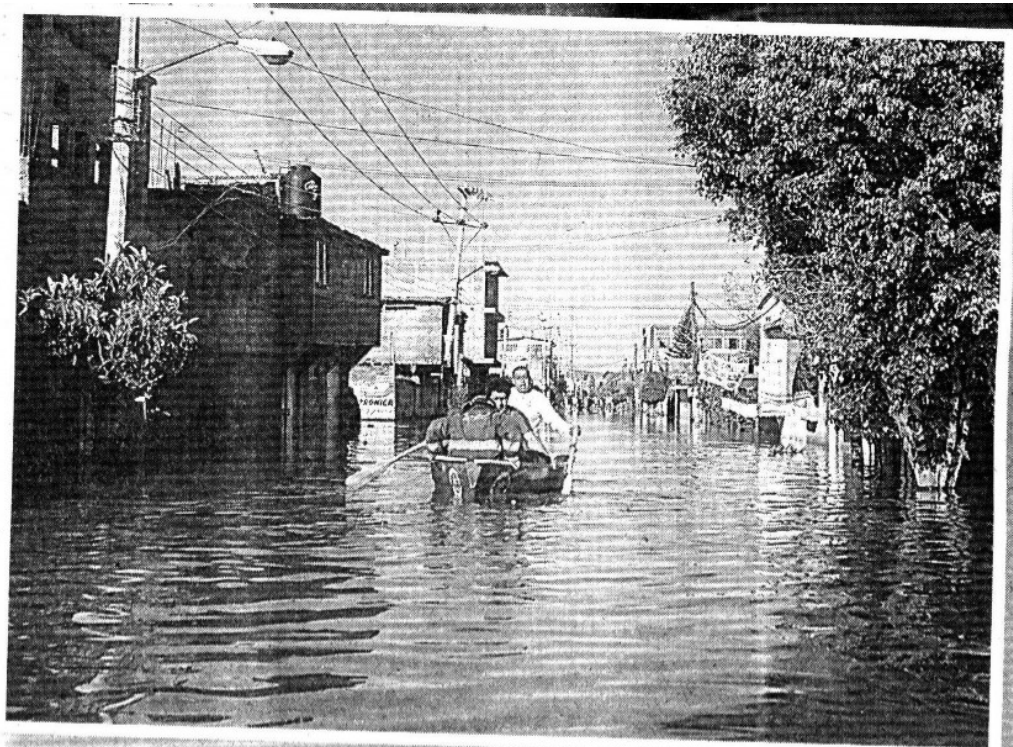
» EL AGUA en varias calles de Chalco alcanzaron hasta un metro de altura, lo que obligó a las personas a trasladarse en lancha.
