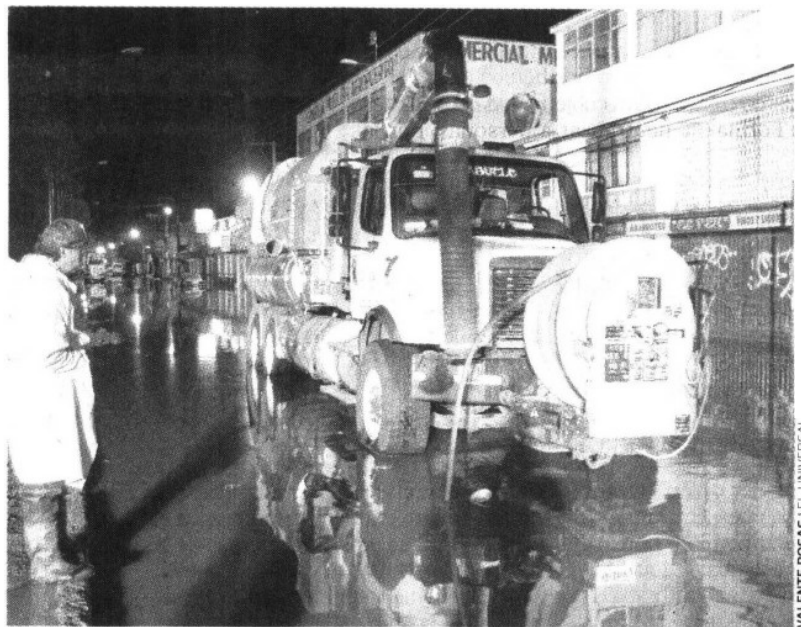
INTENSO. Camiones vactor realizaron desazolve durante toda la noche
