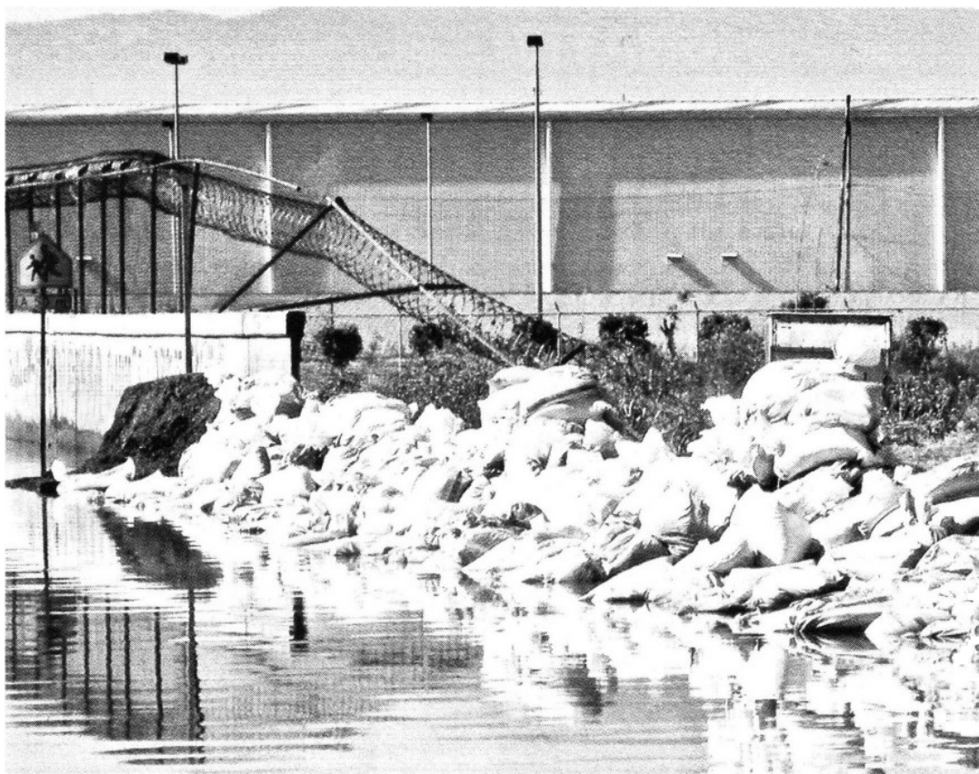
Unas hiladas de costalería contienen el ingreso de la inundación a la zona de hangares del Aeropuerto Internacional de la Ciudad de México... y también impiden el paso.
