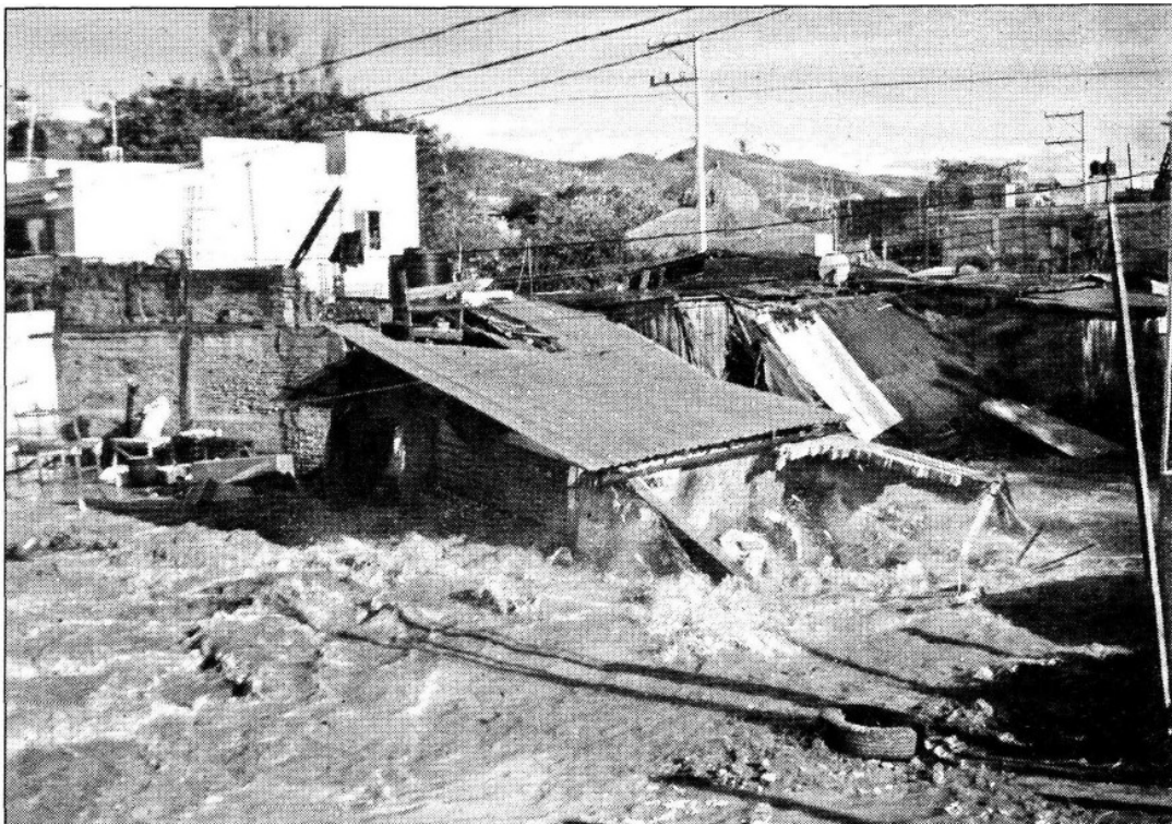
Debido al desbordamiento de la presa Cerrito Rico varias viviendas fueron arrastradas por la corriente al igual que varios vehículos, por lo que autoridades municipales y elementos del Ejército Mexicano se dieron a la tarea de evacuar a cientos de familias de las colonias El Amate, San Rafael Norte, Zona Industrial y Galeana, entre otras, que se ubican al norte de Chilpancingo, Guerrero ■ Foto Óscar Alejandro Alvarado
