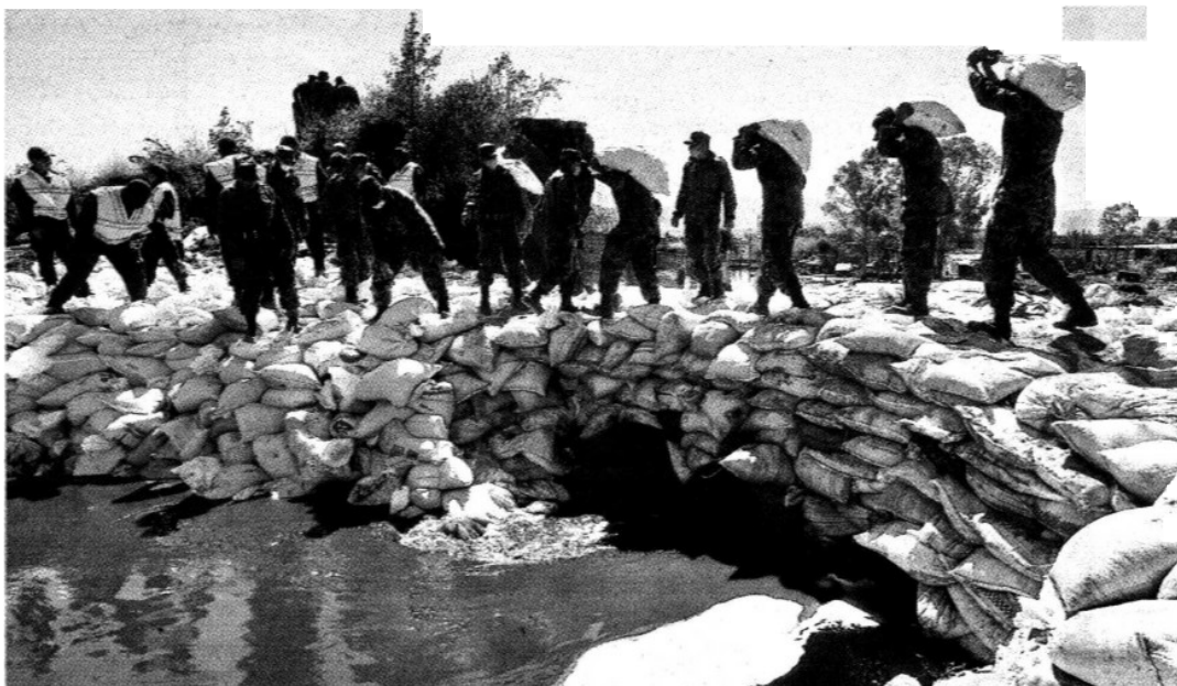
TAPÓN. Militares y elementos estatales contribuyeron en la construcción del dique para detener el paso del agua del Canal de la Compañía.
