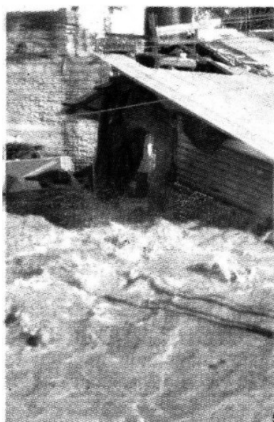
El desbordamiento de la presa Cerrito Rico inundó 671 viviendas de siete colonias
