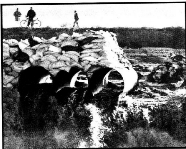
SIN CONTROL, el desborde del canal La Compañía.
