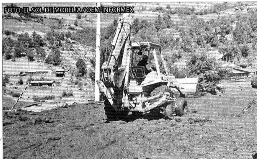
» LOS TRABAJOS de limpieza continúan en el estado de Michoacán.
