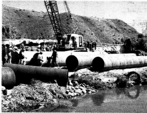
Preparan el entubamiento del canal
