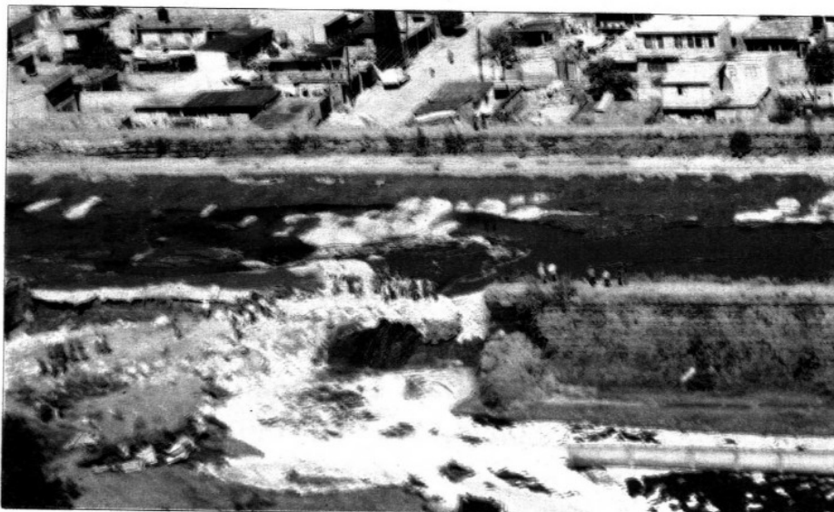
CERROJAZO. Así lucía el boquete del río La Compañía el sábado pasado; hoy más de 200 trabajadores intentan cerrarlo para impedir que siga inundando al Valle de Chalco.
