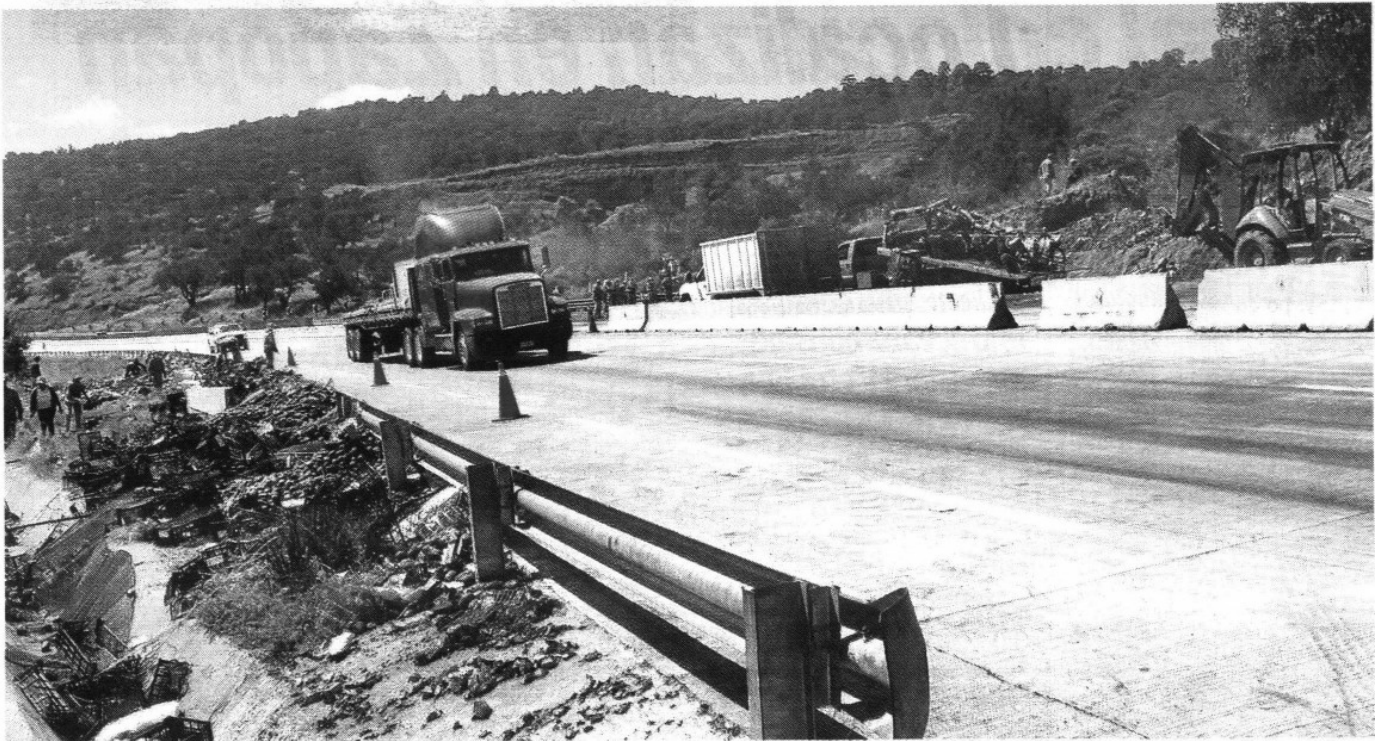
METRO realizó un recorrido ayer en el tramo en el que ocurrió el accidente que cobró la vida de dos personas.
