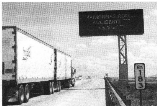
Las señales poco son respetadas por algunos conductores de los vehículos de carga.
