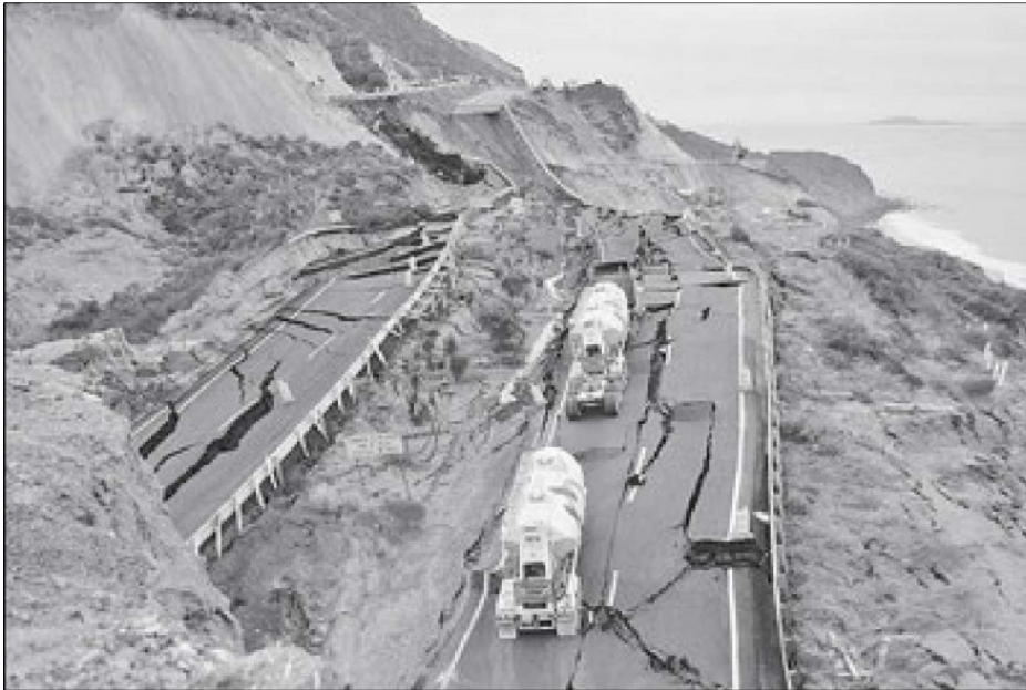
La vía corre paralela a la costa norte del Pacífico mexicano. FOTO: ESPECIAL
