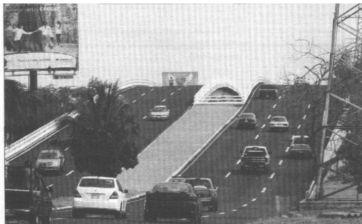
La Secretaría de Comunicaciones y Transportes entregó la nueva infraestructura del distribuidor Venustiano Carranza, en el centro de Colima, con lo que se mejora la movilidad vial urbana.
