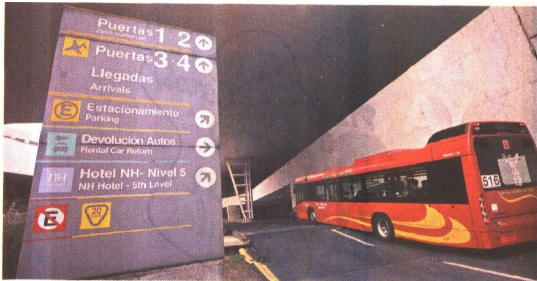
■ La fachada del Edificio Terminal y la zona de la central camionera son de las más afectadas con pisos rotos y desniveles evidentes.
