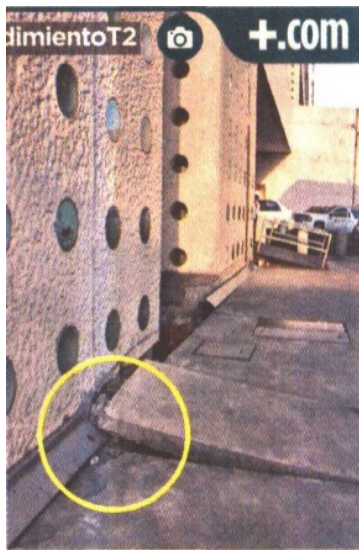
■ El hundimiento en la Terminal 2 del aeropuerto capitalino es diferenciado en las seis estructuras y edificios que la conforman.
