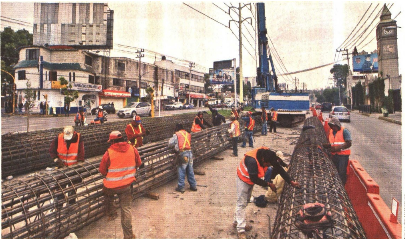
MANOS A LA OBRA Los trabajos de perforación y cimentación iniciaron esta semana y se prevé que la obra concluya en noviembre.
