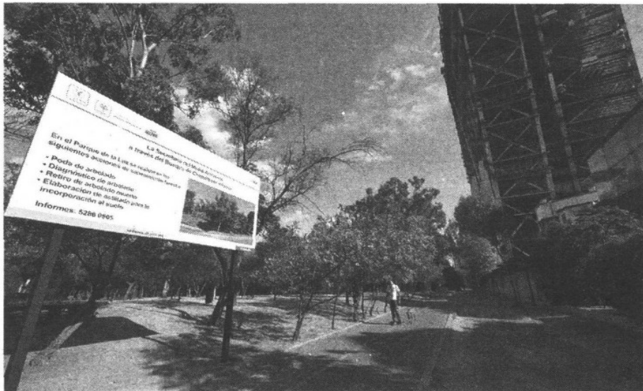
INDIGNADOS. Vecinos denunciaron la tala de árboles en Chapultepec para la construcción de túneles.
