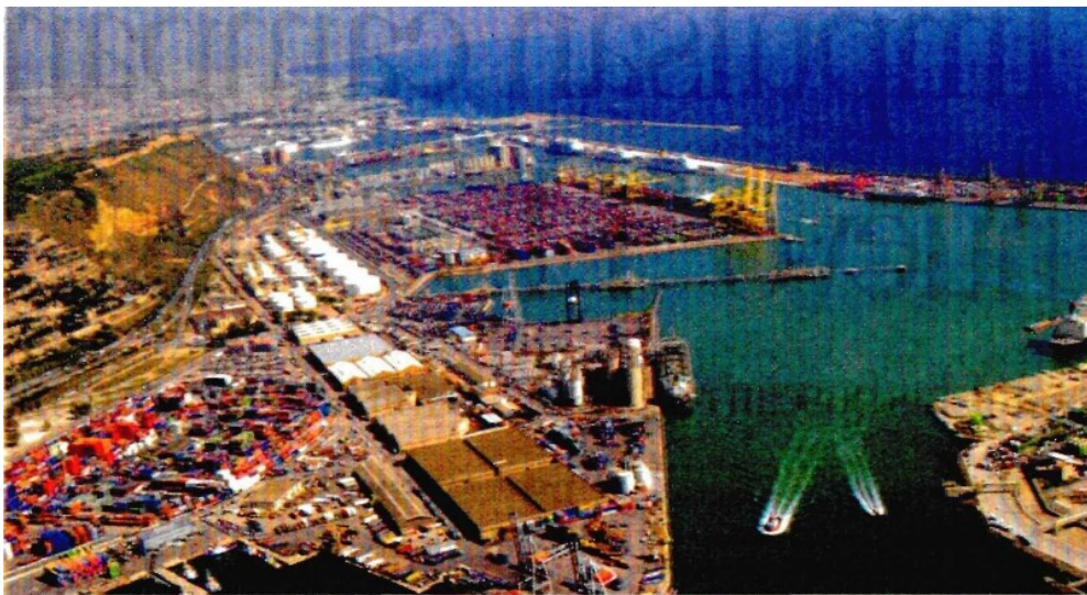
Durante la actual administración se han invertido 23 mil millones de pesos para aumentar la capacidad del Puerto.
