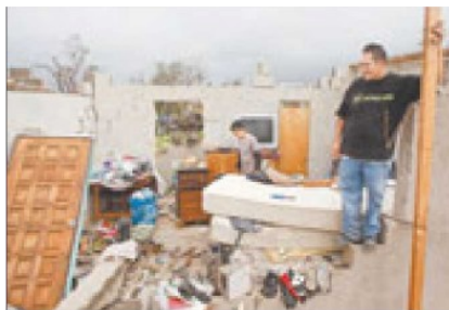
Odile causó a su paso destrucción y graves daños a la infraestructura urbana. Además dejó miles de afectados.
