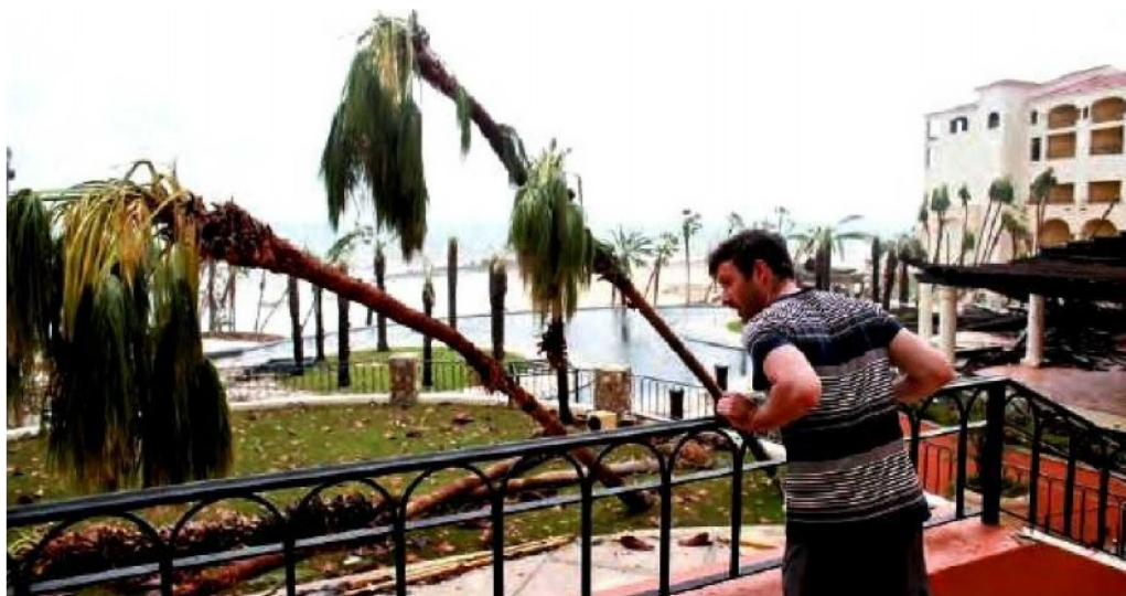
La infraestructura turística v hotelera quedó seriamente dañada.
