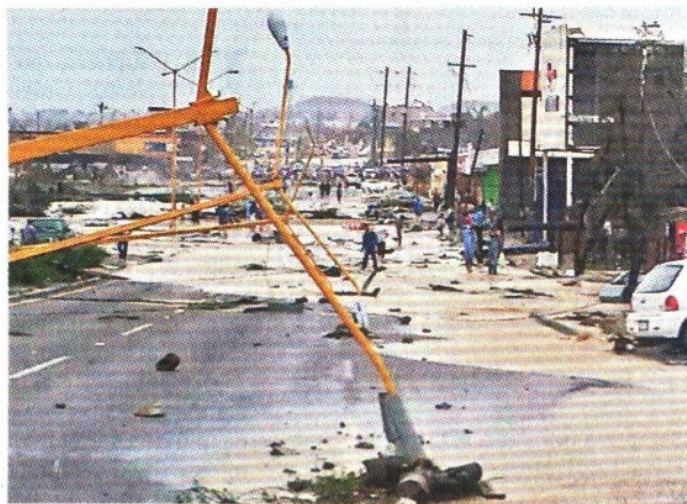
El paso del huracán “Odile” dejó grandes daños sobre todo en la red eléctrica.
