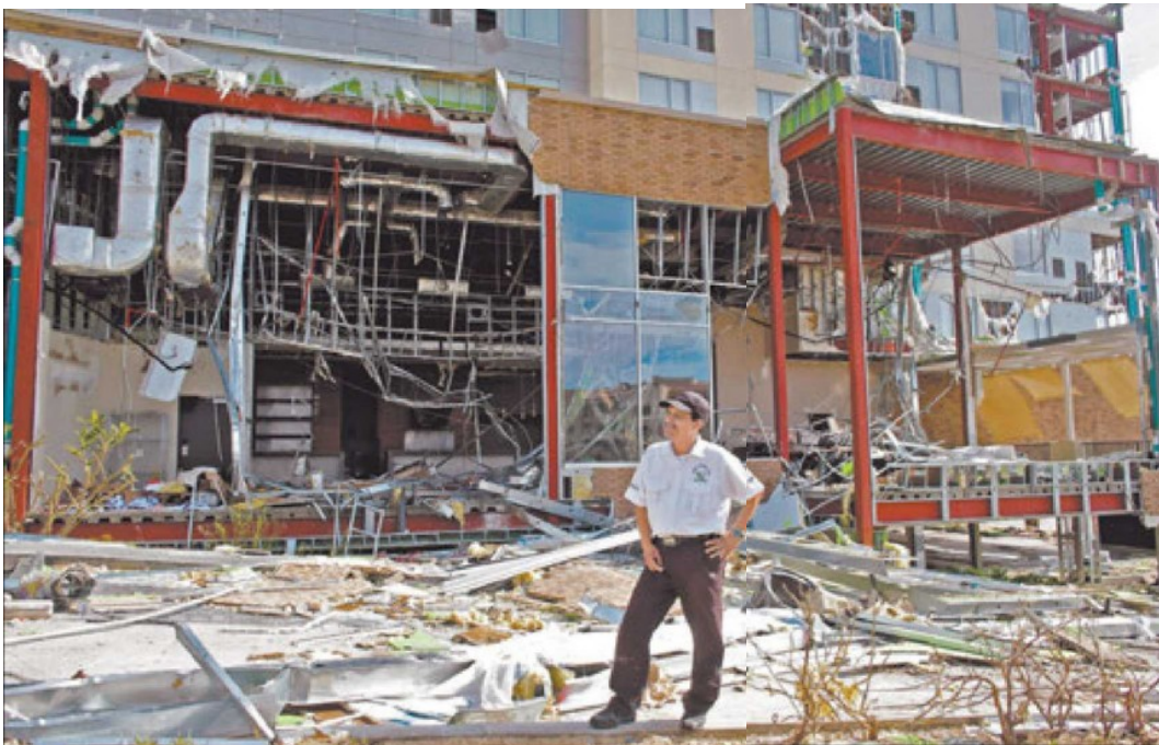
La infraestructura hotelera, con más de 13,000 habitaciones en cerca de 70 hoteles, sufrió daños severos. FOTO: AP
