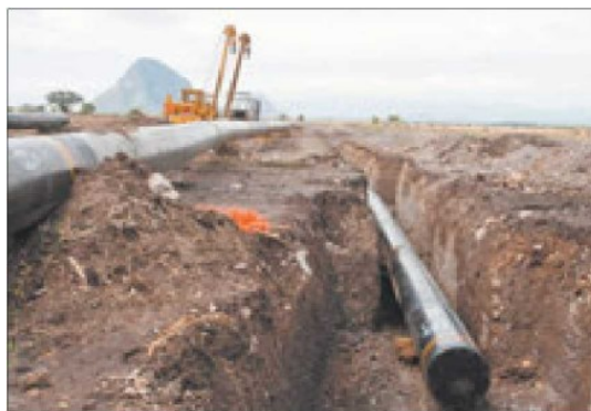
Infraestructura inter-estatal. El Gasoducto Morelos llevará gas natural a tres entidades. FOTO ARCHIVO: CUARTOSCURO
