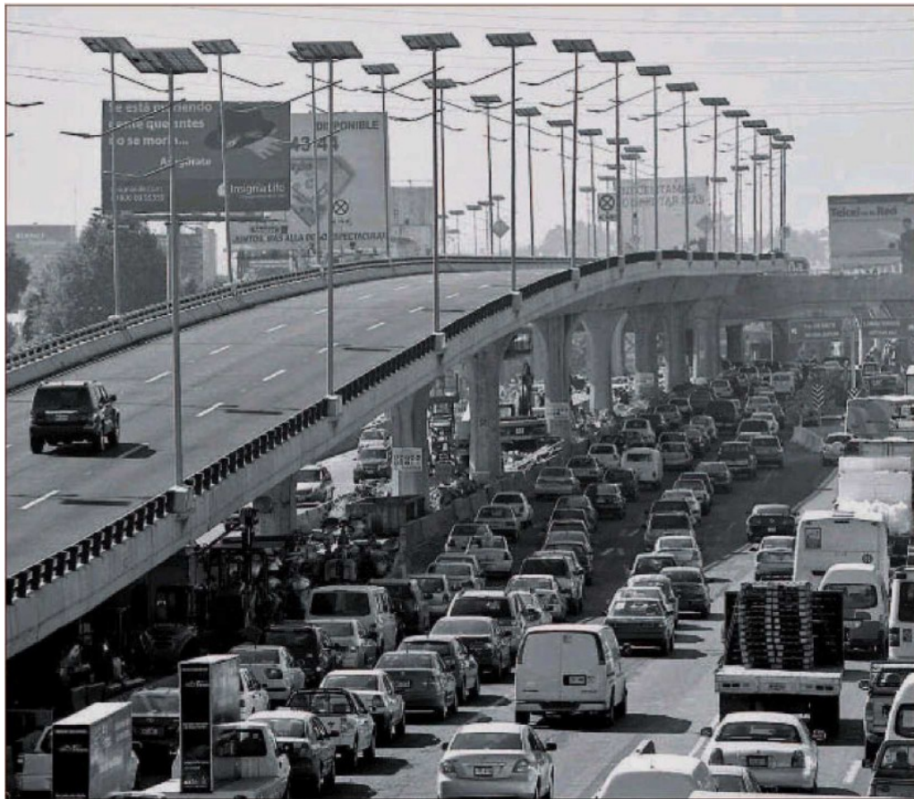
Un coche pasa por el Viaducto Elevado, tramo de peaje que gestiona OHL en Ciudad de México. / BLOOMBERG
