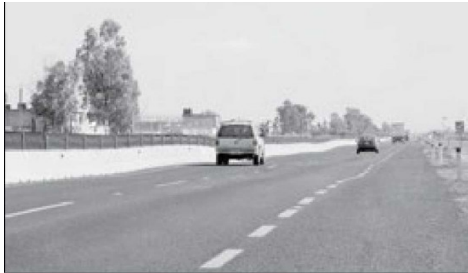
Circuito Exterior Mexiquense , obra construida por OHL y que es parte de un litigio entre Infraiber y el SAASCAEM por la operación Siva.
