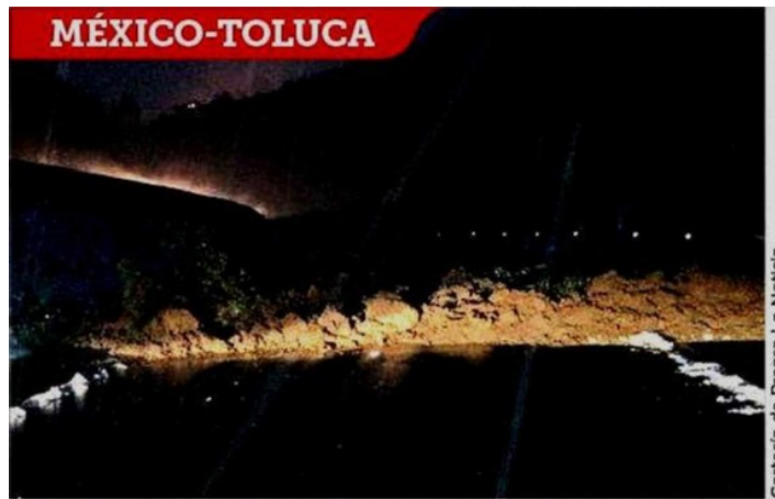
■ El deslave obligó a desviar a los automovilistas hacia la carretera libre para llegar a la Ciudad.
