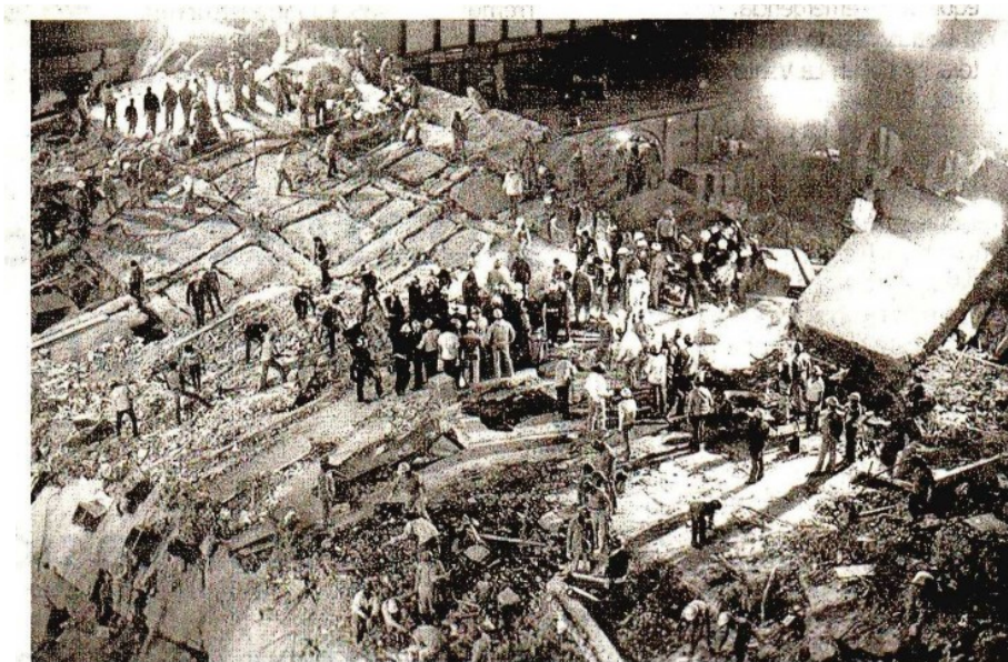
Imagen nocturna en la que se aprecia el trabajo de los rescatistas en el plantel del Conalep, que colapsó con el temblor de 1985, en la calle de Iturbide.
