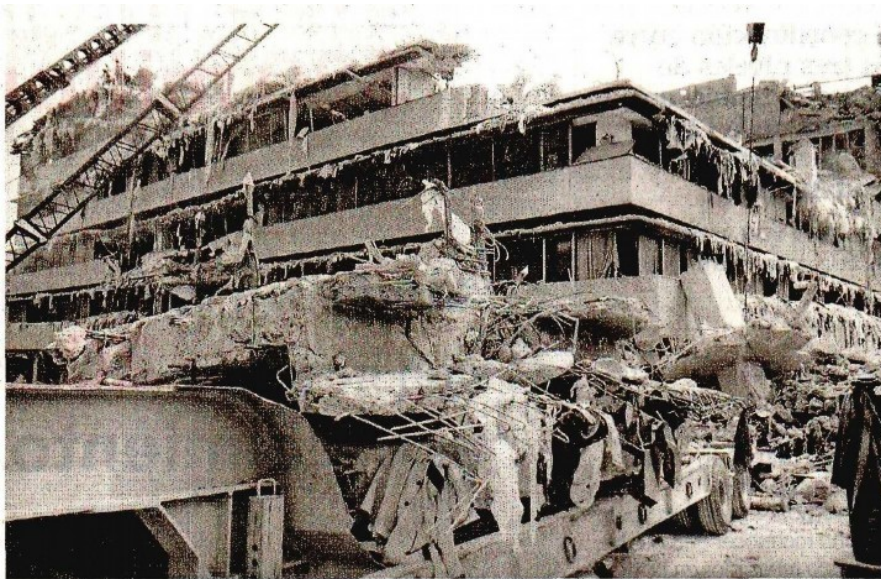
Días después de la búsqueda de sobrevivientes entró la maquinaria pesada para retirar los escombros de esta fábrica, en la esquina de San Antonio Abad y Gutiérrez Nájera.
