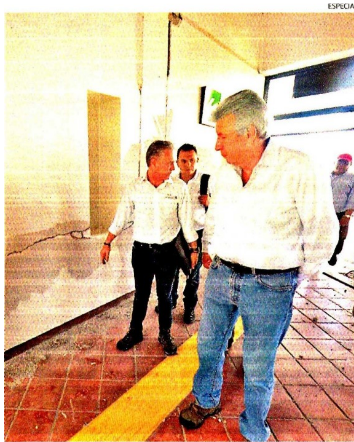
El titular de la SCT, Gerardo Ruiz Esparza, constató daños.
