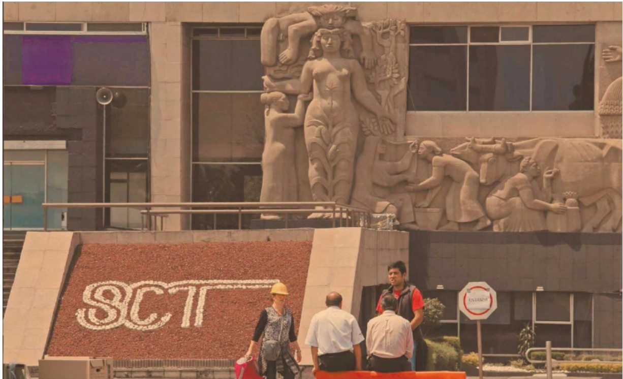
El edificio de la Secretaría de Comunicaciones y Transportes, en Xola y Eje Central, es uno de los inmuebles que sufrió daños. FOTO EE: HUGO SALAZAR
