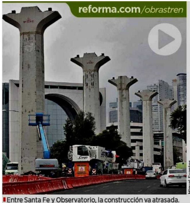
Entre Santa Fe y Observatorio, la construcción va atrasada.
