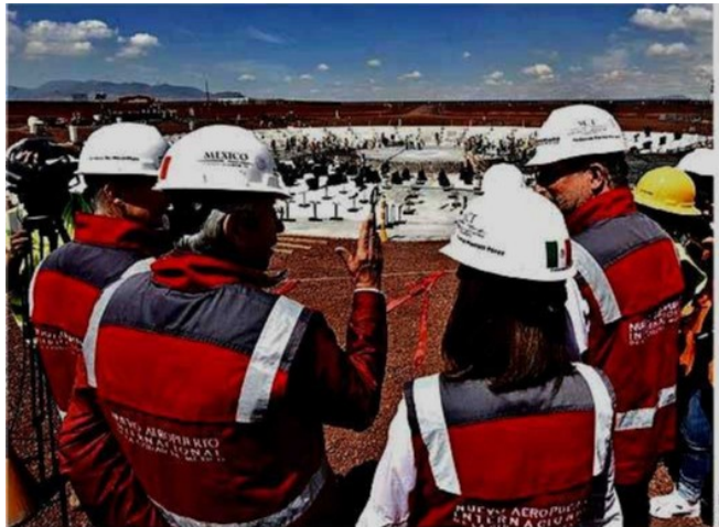
El titular de la SCT, Gerardo Ruiz Esparza, y el Gobernador del Estado de México, Alfredo del Mazo, supervisaron los avances en las obras del NAICM.
