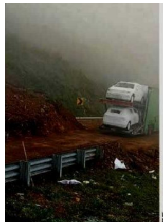
El deslave en la carretera afectó la circulación.
