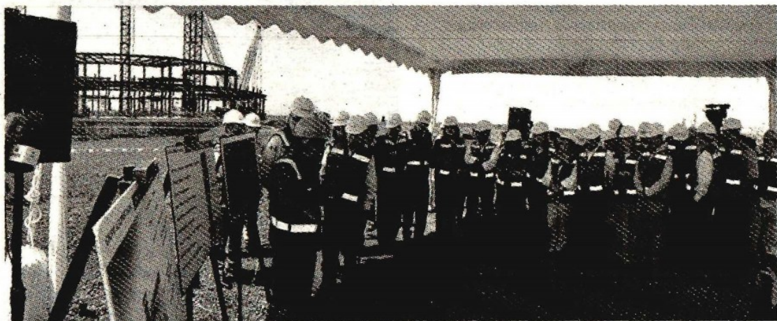
Junto con senadores de la República, el secretario de Comunicaciones y Transportes, Gerardo Ruiz Esparza, supervisó el avance de obras del Nuevo Aeropuerto
